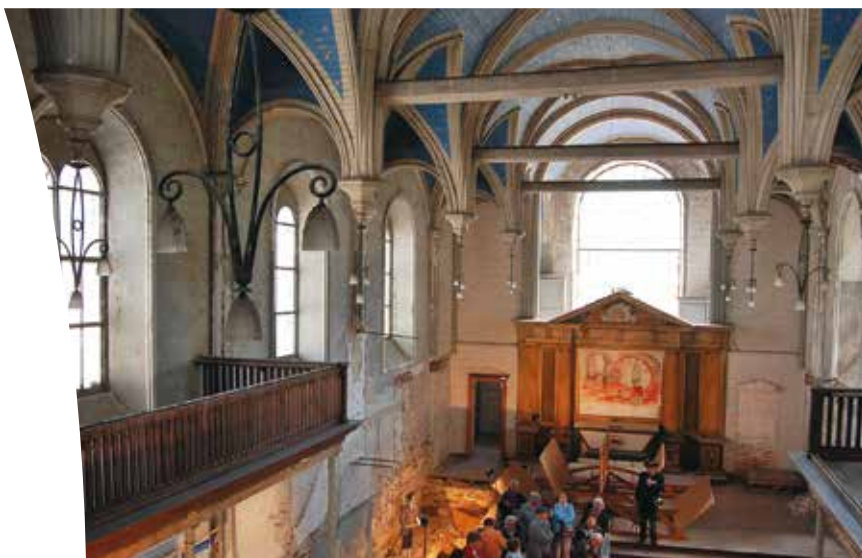
Dans la Forerie-chapelle d'Indret sont inscrits à l'Inventaire le sol et les infrastructures voûtées du moulin à marées (1777) ainsi que la voûte en charpente (1842) avec ses luminaires
